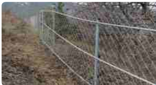
능형철망 3단 하단부 보강공사
