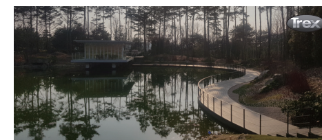
데크 국내 유일 S커브 시공
