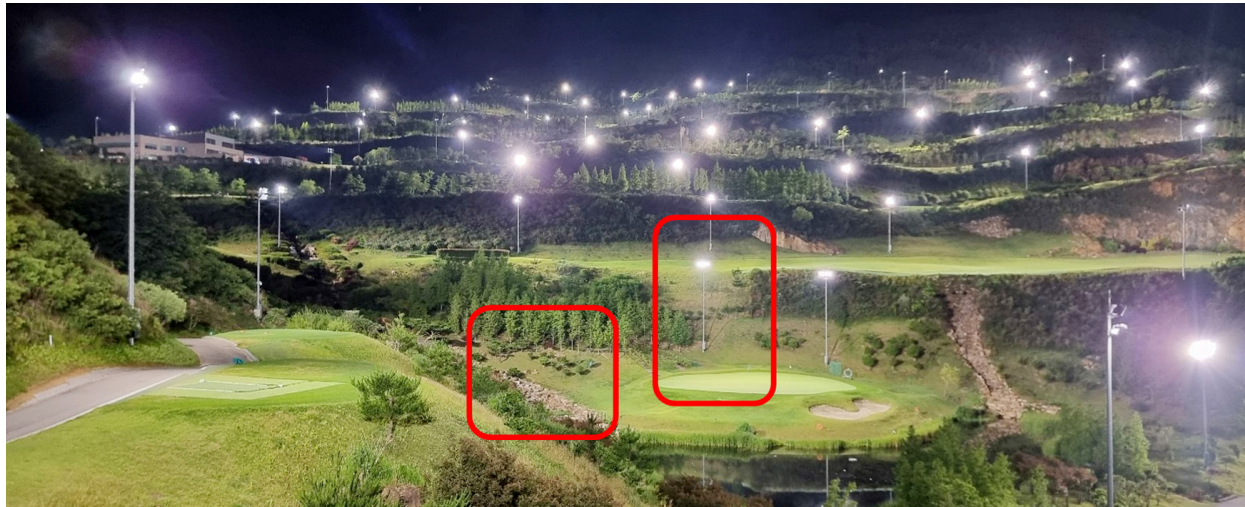
주요 공사 사진 다이아몬드 CC
