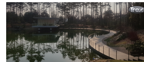
데크 국내 유일 S커브 시공
