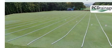
배수개선 국내 최단시간 시공
